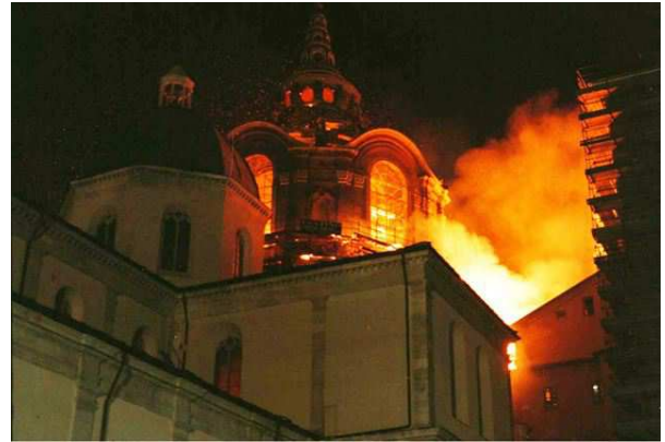
La cappella durante l'incendio
